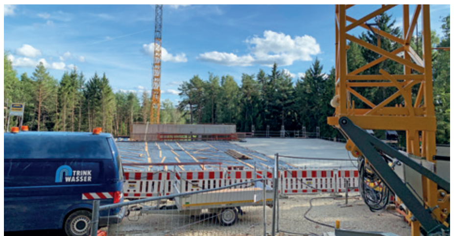
Die fertig gegossene Betondecke des neuen Hochbehälters.
