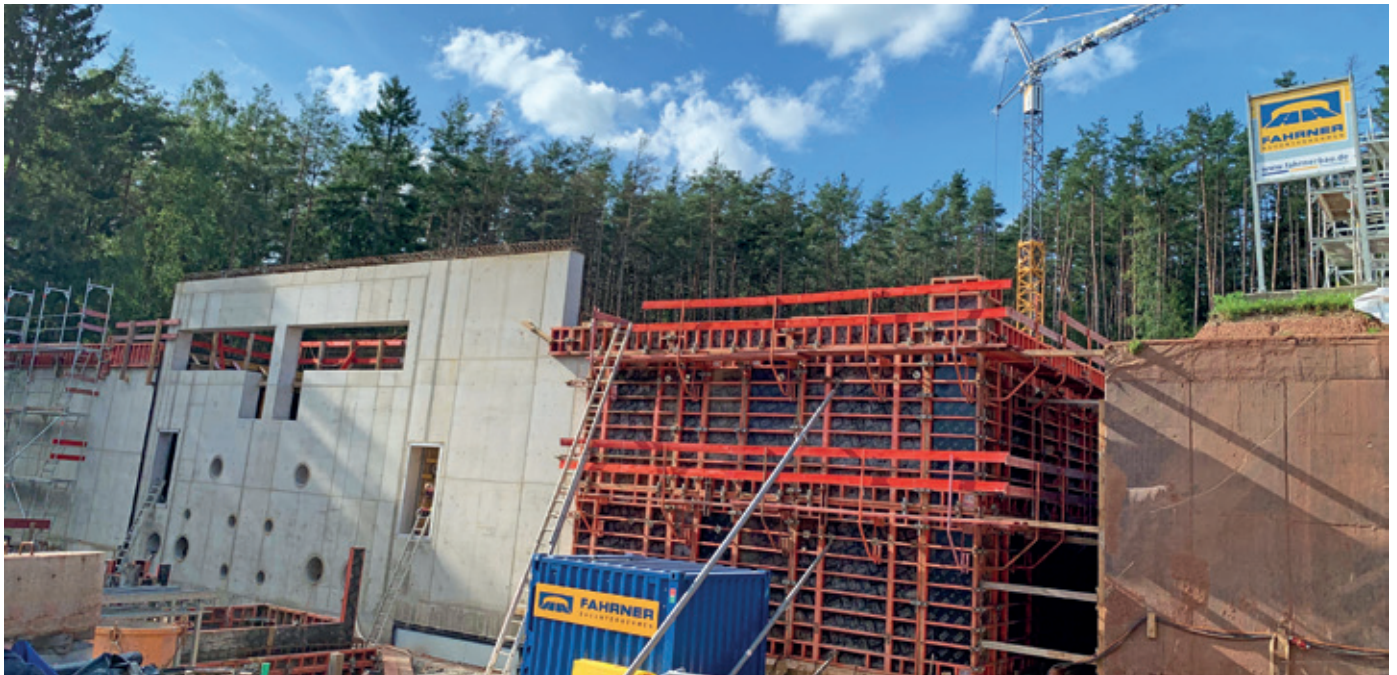
So sah die Baustelle am Westenberg im September aus, als die Betonarbeiten weitgehend abgeschlossen waren.
